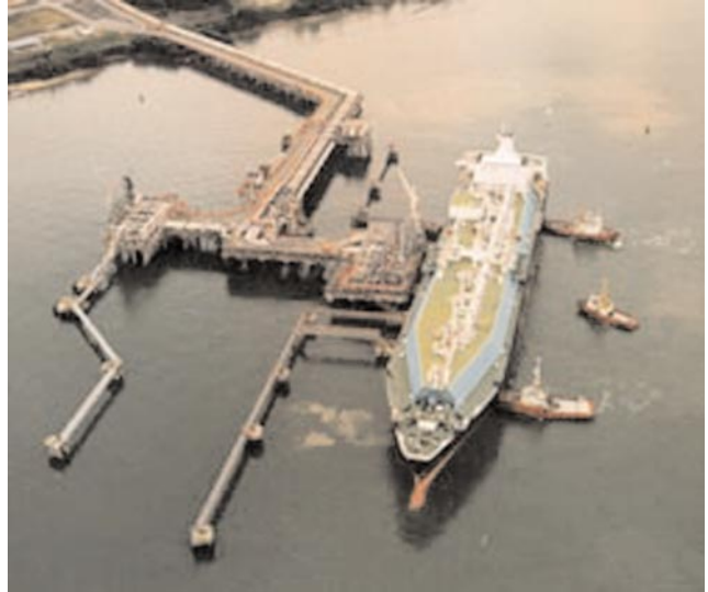
LNG Jetty—Berth No. 2
